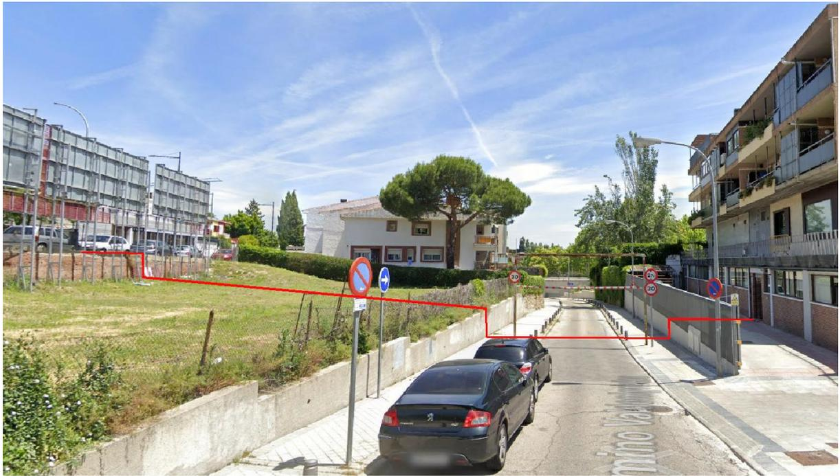
En línea roja se aprecia la sección transversal del terreno y cómo el camino de Valdenigrales se desarrolla en "trinchera", manteniendo por encima de su rasante el terreno natural de las parcelas a ambos lados de la calle. La sección siguiente muestra este corte:
