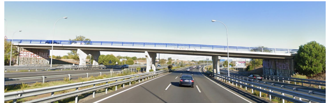
PASO SUPERIO EXISTENTE SOBRE M40 (ENLACE M513)
