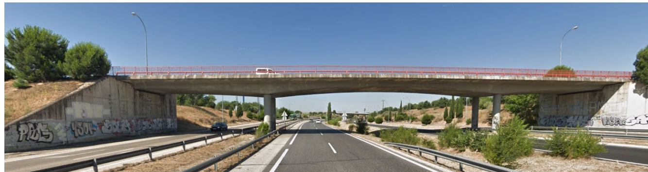
PASO SUPERIO EXISTENTE SOBRE M503 (ENLACE M515)
