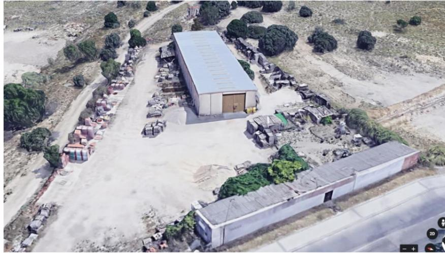
En primer plano: construcción alargada de muros de fábrica de ladrillo y cubierta de fibrocemento a un agua.
