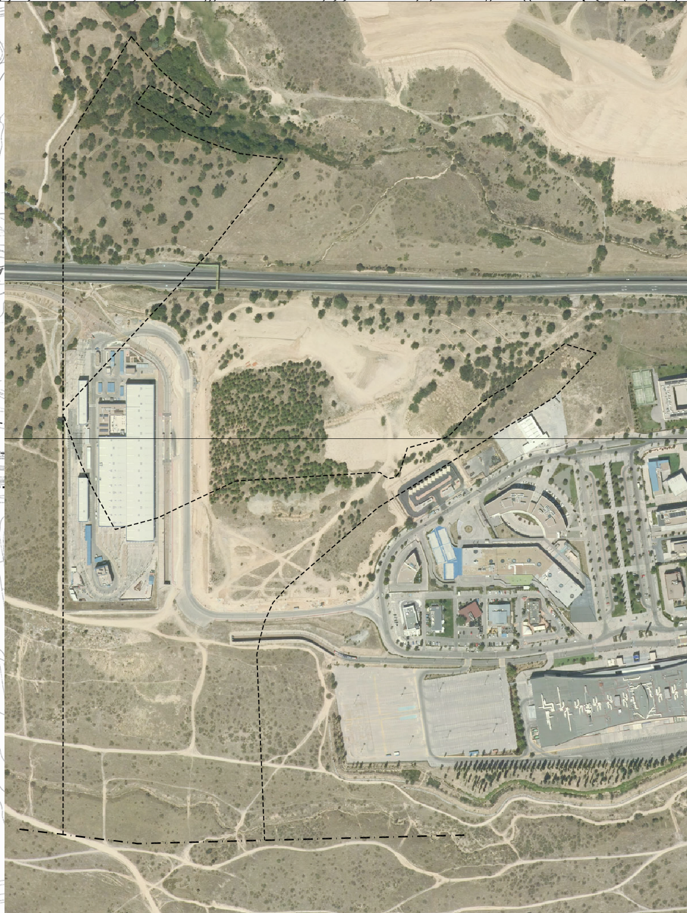
ORTOFOTO (AÑO 2020) EN LA PRESENTE FOTOGRAFÍA NO SE VEN REFLEJADAS LAS OBRAS ACTUALMENTE REALIZADAS (DESDOBLAMIENTO DEL VIARIO DE ACCESO Y GLORIETA).
