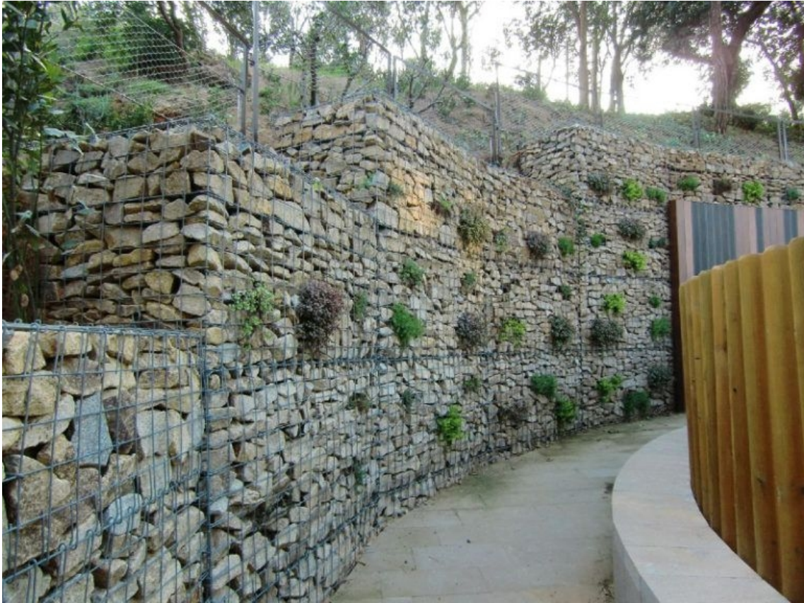
Ejemplo del uso de gaviones en parque urbano
