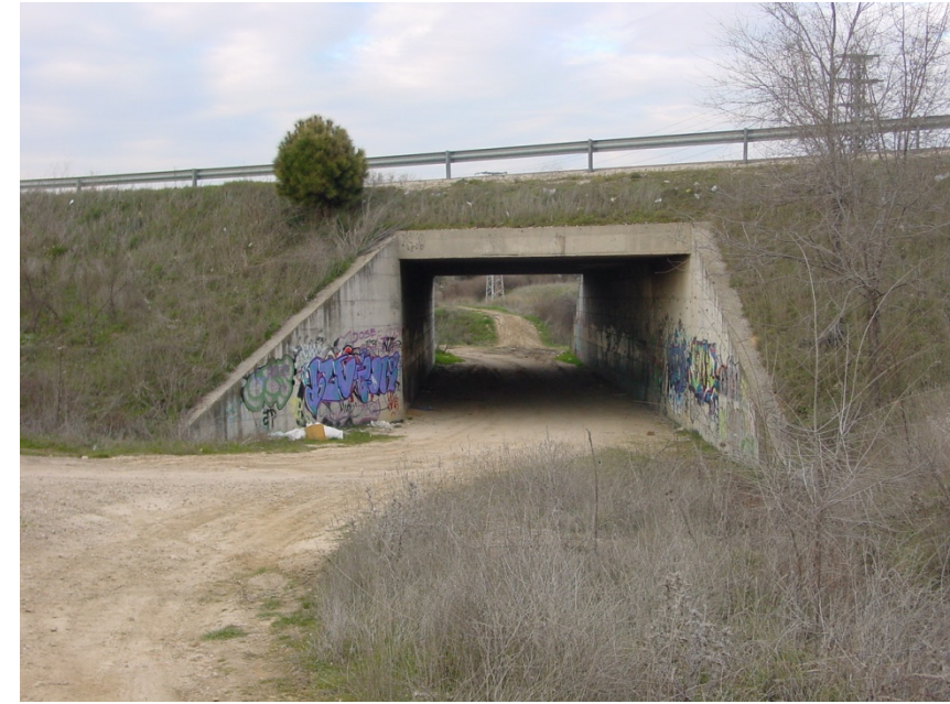
Foto 9. Vista de la obra de paso para camino local bajo la M-503, al lado de la cual hacia la derecha de la foto se sitúa la obra de fábrica para el paso del arroyo Las Viñas de Alcorcón.
