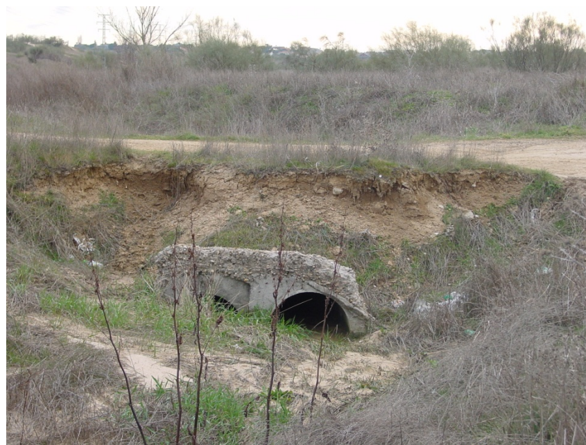
Foto 6. ODT-5 Vista del entubamiento actual del cauce del arroyo Las Viñas de Alcorcón, constituido por dos tubos de hormigón de 0,80 m de diámetro.
