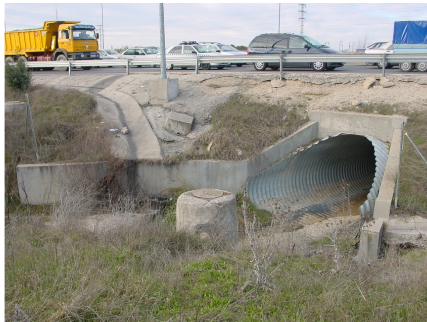
Foto 2. Vista en detalle de la ODT-3, del cauce del arroyo de las Pozas en su paso bajo la M-503, con una sección abovedada de dimensiones 4,15 m de ancho x 2,90 m de alto. La O.F. se compone de boquilla y aletas de hormigón en ambos extremos y el tubo es de chapa de acero corrugada tipo ARCO. Se aprecia además el aporte del drenaje pluvial de la calzada a través de la cuneta de hormigón.
