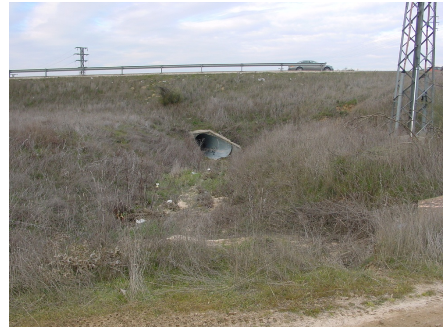
Foto 8. Vista de la obra de fábrica bajo la M-503, situados sobre el camino local bajo el que se encuentran los dos tubos de hormigón anteriores.
