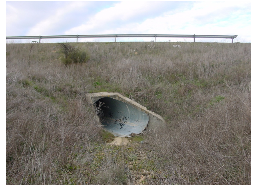
Foto 4. ODT-6 en M-503. Arroyo de Las Viñas de Alcorcón. Vista aguas arriba.
