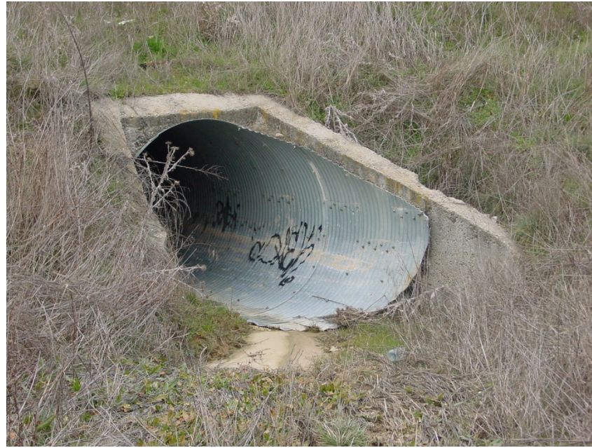
Foto 5. Detalle de la ODT-6 que recoge en la actualidad los caudales pluviales del arroyo de Las Viñas de Alcorcón para su paso bajo la M-503, consistente en boquilla y aletas de hormigón en ambos extremos y el tubo es de sección circular, de chapa de acero corrugada tipo ARCO, con unas dimensiones de 1,80 m de diámetro.
