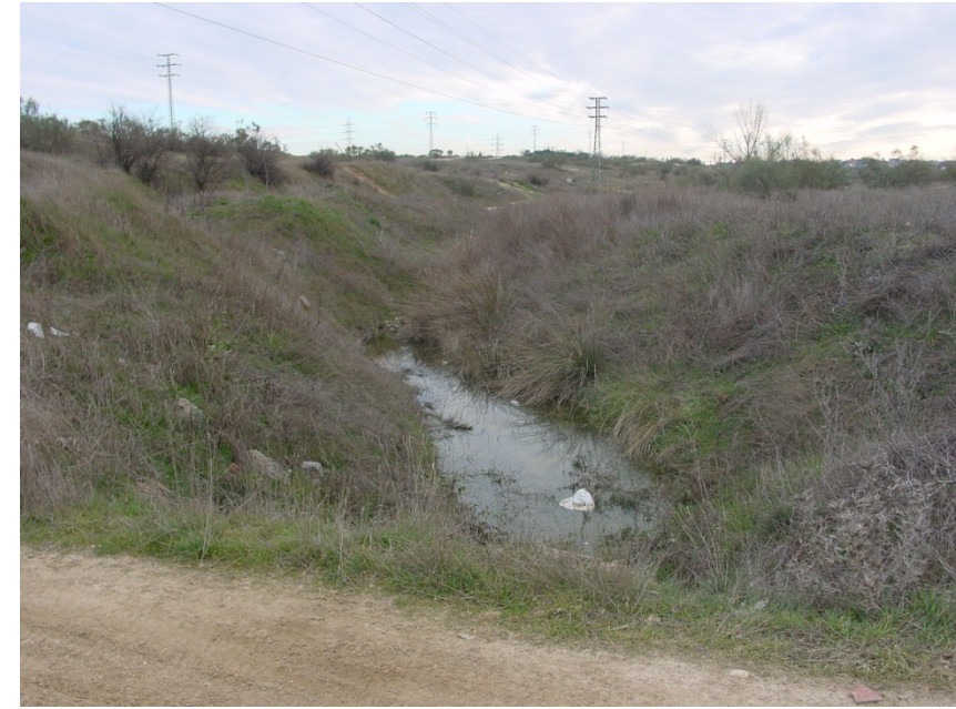
Foto 7. Vista del cauce del arroyo Las Viñas de Alcorcón desde el camino bajo el que se sitúan los dos tubos de la obra de fábrica anterior, mirando hacia aguas arriba del cauce.
